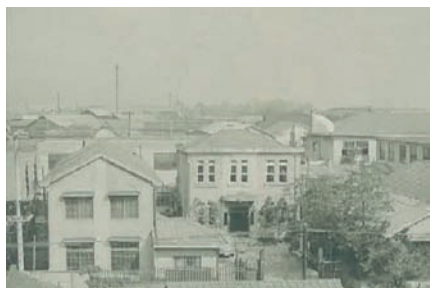
Impianto di produzione di Tokyo, 1923
